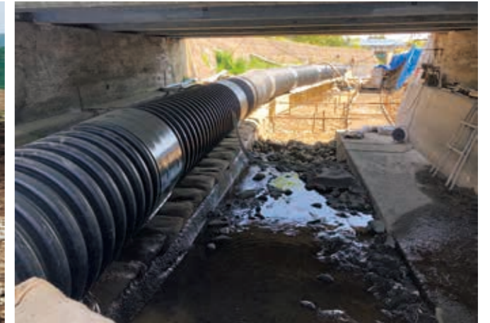
河川改修排水工事
