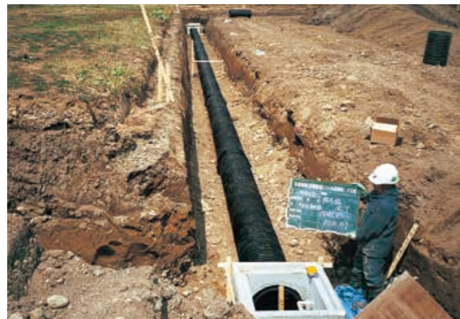
小排水路の管路化工事
