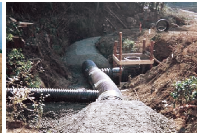
土捨場防災暗渠工事
