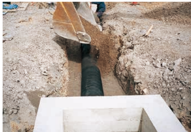
NEXCO用排水管工事
